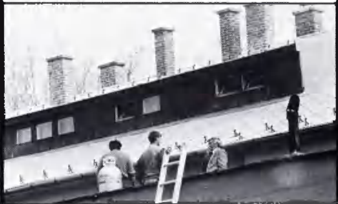
A MOL Rt. Munkásszálló – Gellénháza – tetőszerkezetének átépítése.
