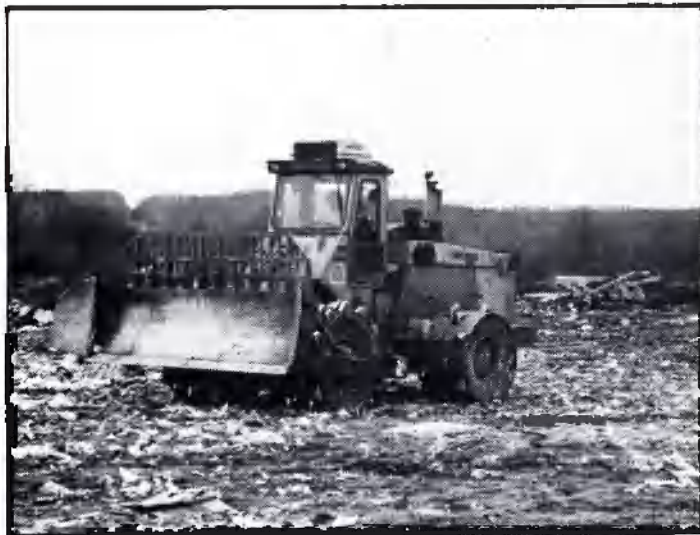
A kompaktor által kialakított sima és tömör felület.
