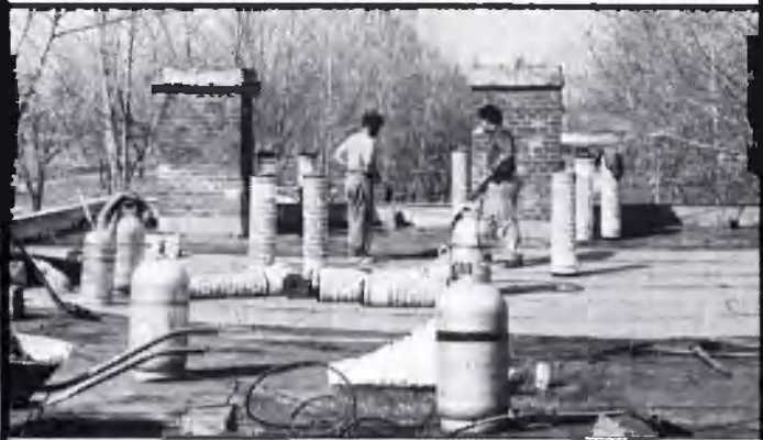
Nagykanizsa Megyei Jogú Város Önkormányzatának lakásfelújítási munkáinak keretében végzett lapostető-szigetelés.
